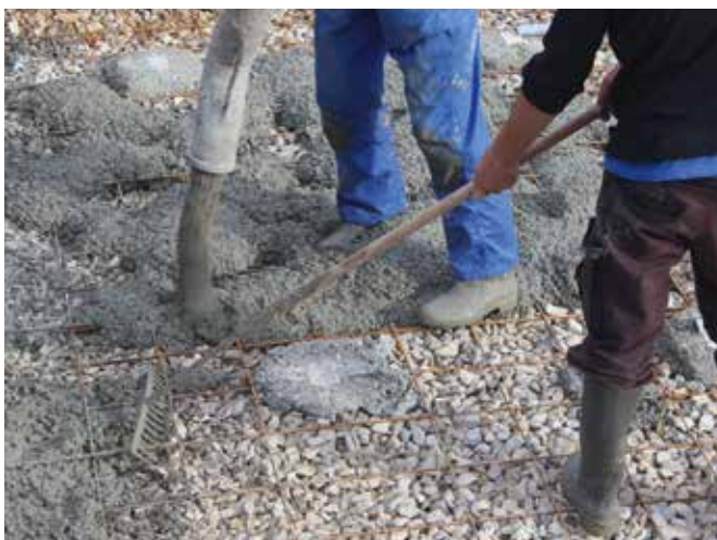
Coulage fond plat
