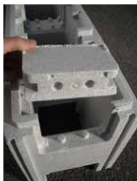
Bouchon haut avant mise en place
