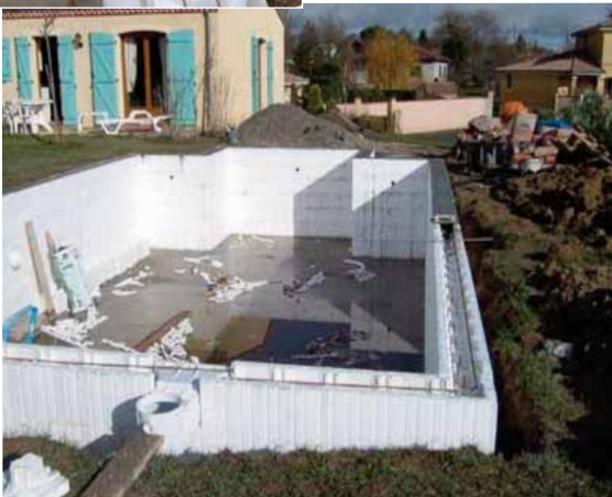
Bétonnage en voie de finition
