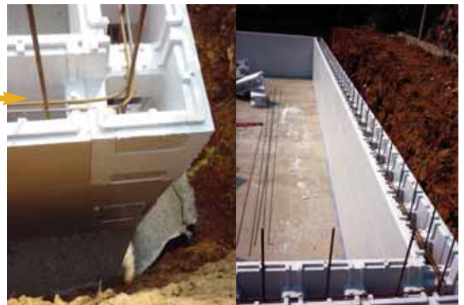
Partie à découper pour le passage des fers à béton et du béton
