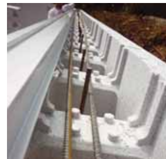
Détail bloc et ferrailage du rang supérieur
