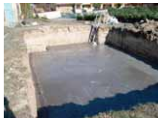
Vue du radier réalisé plat de niveau
