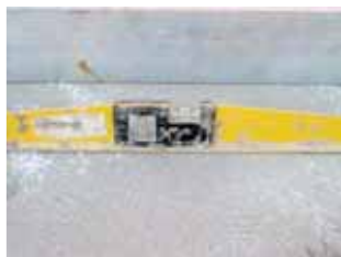
Vue du radier réalisé plat de niveau
