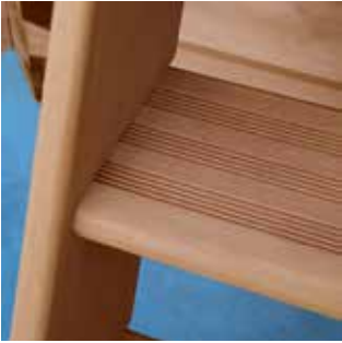
Escalier extérieur en bois tropical dur
